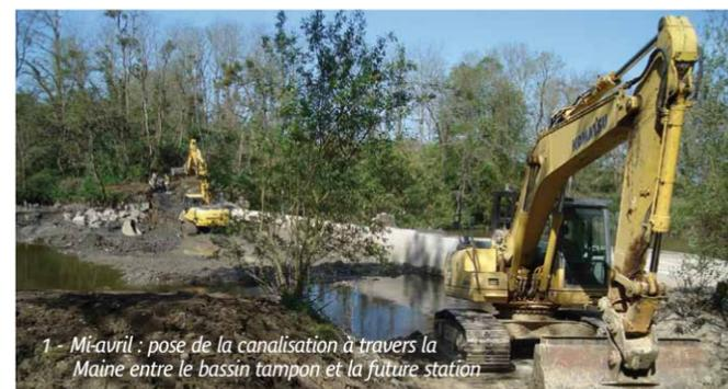
1 - Mi-avril : pose de la canalisation à travers la Maine entre le bassin tampon et la future station
