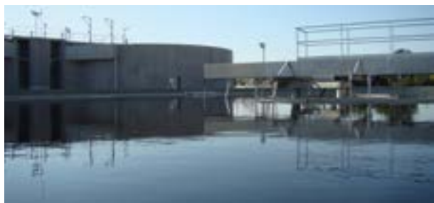
Station épuration - Montaigu-Vendée (Saint-Hilaire-de-Loulay)
