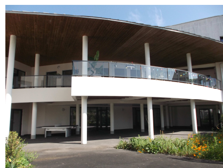
Bâtiment A « AUGEREAU »
