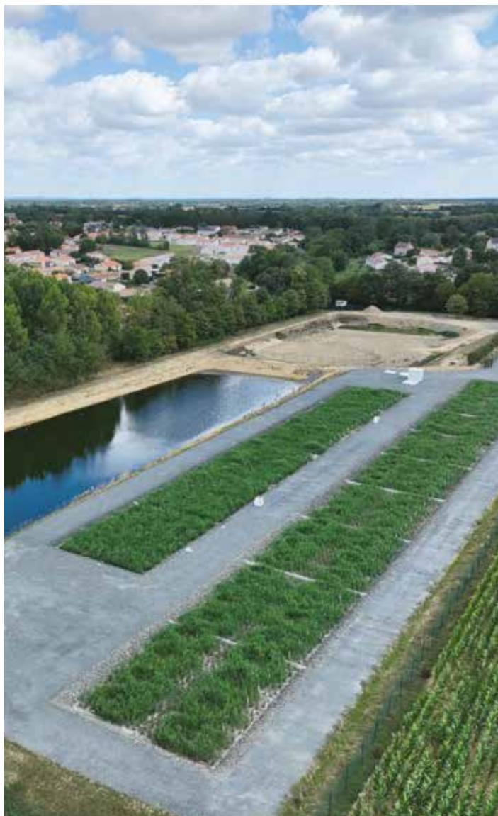
Station d'épuration (Montréverd)
